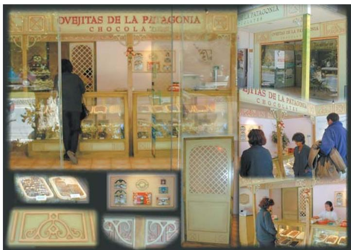
Marquesina construida en madera con un router. Puede apreciarse el trabajo de corte, grabado, calado y encastre.
